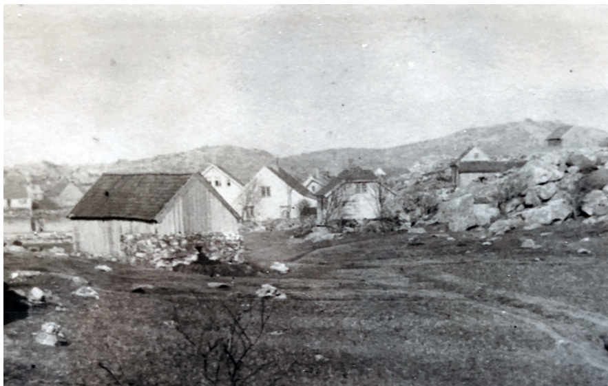
Køstehuset, med halvvalm, lå på Køstestykket like sør for tollbua (med lyst bryst). Huset ble bygd i 1816 og tatt ned omkring 1906 og deretter satt opp igjen annet sted i Tananger. Foto i privat eie.
